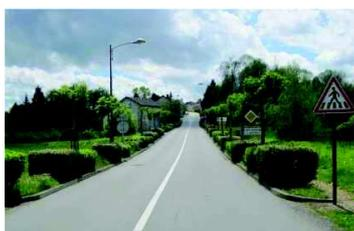
accompagnées ou non par une coloration transversale (résine colorée par exemple), créent déjà une sensation de « rupture ». Une modification du type de marquage horizontal contribue également fortement à la modification de la typologie de la route.
