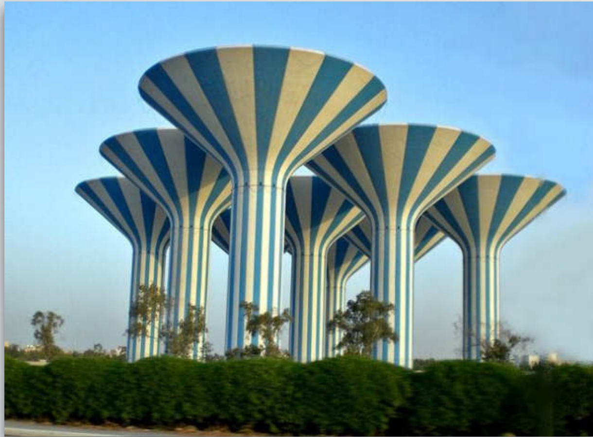
Châteaux d'eau à Koweït City
